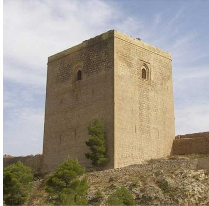
La torre tiene planta rectangular, cuyas dimensiones exteriores son 22,60 m por 19,55 m y una altura de 30 m.
